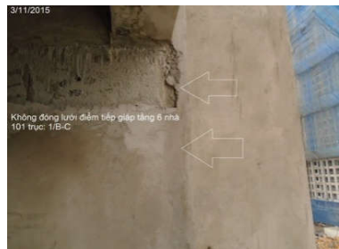
15. CÁC VỊ TRÍ GIÁP MÍ KHÔNG PHẪNG, BỀ MẶT CHỨA NHIỀU TẠP CHẤT
