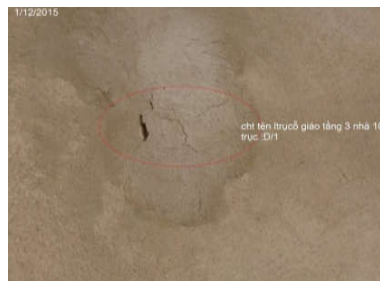
14. TƯỜNG BỊ BAI CHÂN DO KHÔNG CẮT CHÂN TƯỜNG
